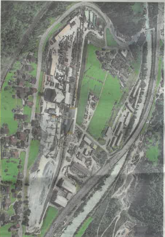
So sah das Gebiet Grund in Amsteg zu Zeiten des Near-Tunnelbaus aus.
